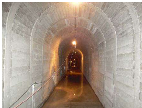
農業基盤整備事業により整備された 西の原用水の隧道
