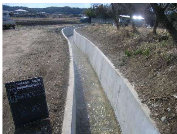
農業基盤整備事業で整備された用水路
