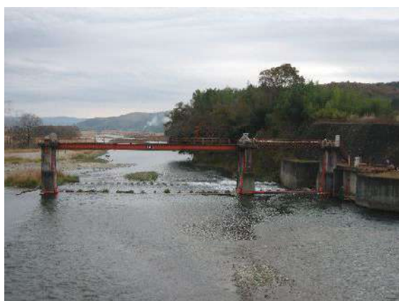
箒川に架かる西の原頭首工
