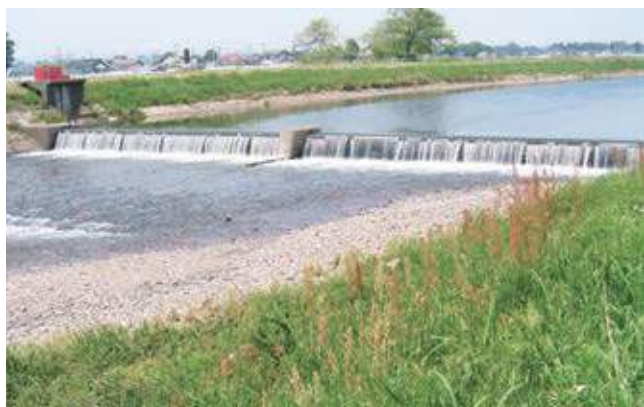
一級河川田川の三つの取水堰の一つ蟹川堰現在改修計画中
