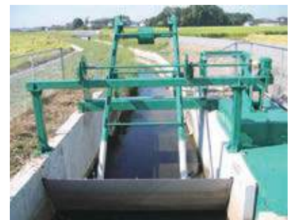
五千石用水の 5 基設置された取水堰（ウォッチマンゲート）の一つ
