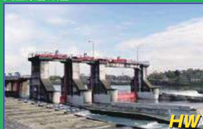
小山市土地改良施設カードNo.4
