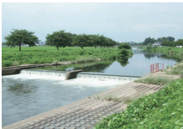
横田大堰（五行川東地区）
