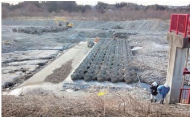
片田北滝地区 平成 28 年度農地耕作条件改善事業による (取水施設補修工) 那珂川より取水
