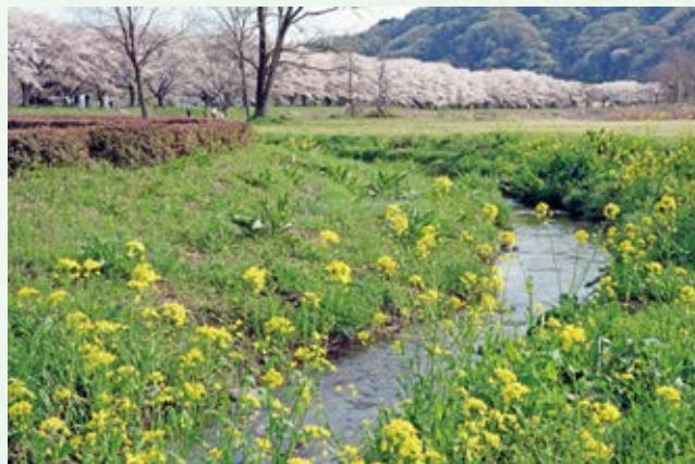
沿線一帯を洪水被害から守るために開削された放水路は大芦川の桜づつみのもとに放流されます。
