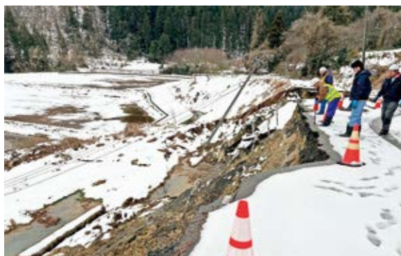
大きく崩れている農地
