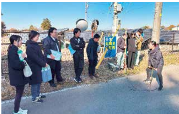
恵川地区管路調査の様子
