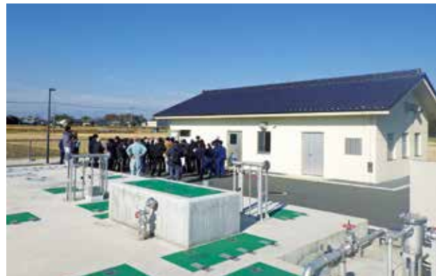
旭町・星の宮地区処理場調査の様子
