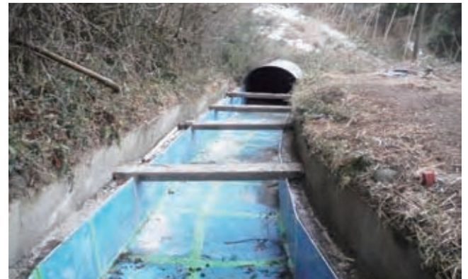
大川地区 平成 25 年度農地耕作条件改善事業による (レジンコンクリートパネル補修工) 那珂川より取水
