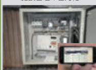
監視装置の設置
