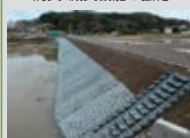
ため池護岸の整備
