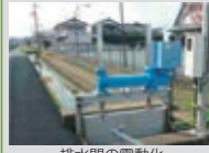
排水門の電動化
