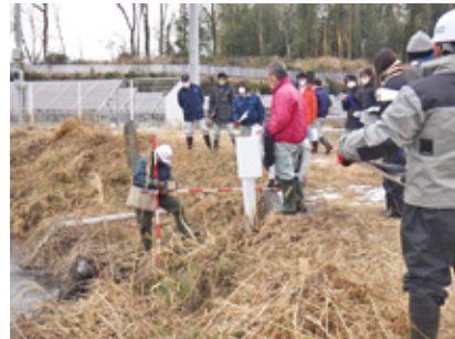
堤体変形調査
