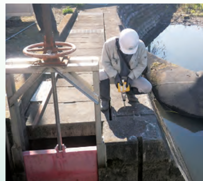
施設機能診断
