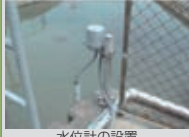
水位計の設置
