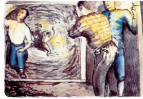
那須疏水工事
