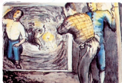
那須疏水工事
